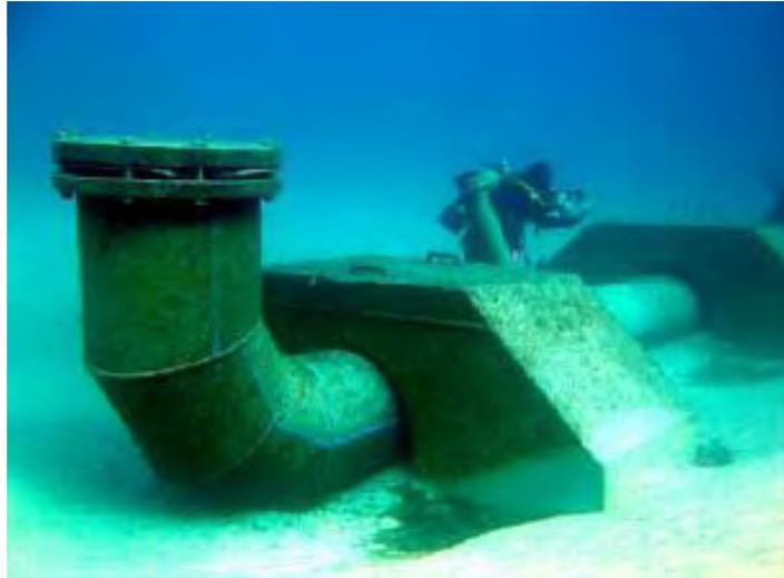
**Figura 19.-** Detalle de un emisario submarino para el vertido de agua hipersalina. Los difusores de este tipo de emisarios suelen estar orientados con un ángulo entre 45° y 60° respecto al fondo marino.
