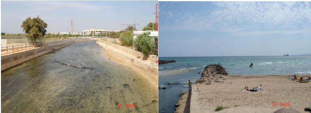
**Figura 23.-** Vertido de agua hipersalina a través de una rambla en un tramo litoral de las Islas Baleares. La dilución que se consigue en estos casos es muy baja.
